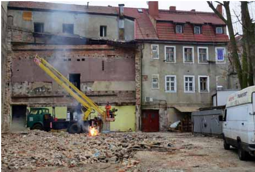
Abriss des Kino „Piast“, Dezember 2012 / Rozbiórka kina, grudzień 2012 Foto / zdjęcie: Karl-Konrad Tschäpe
