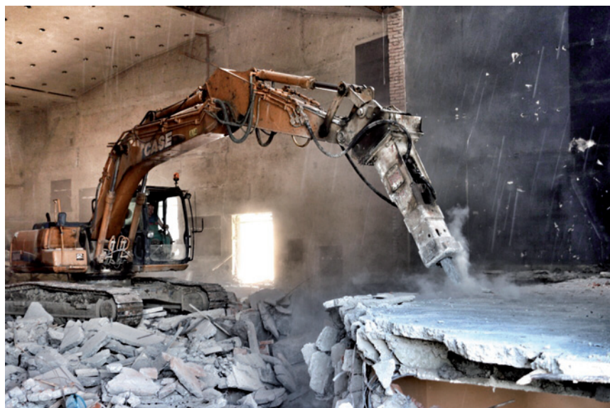
Burzenie sceny w sali widowiskowej Limanowskiego Domu Kultury. Fot. UG Limanowa
